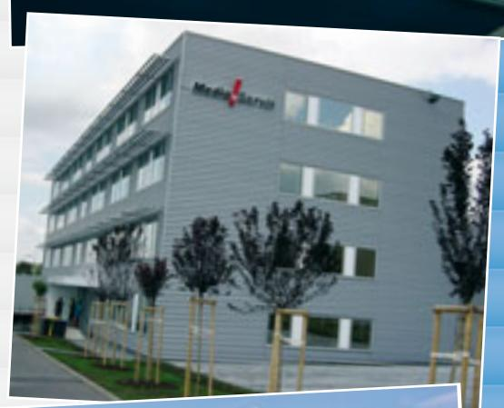
třech velikostech, nebo plechové vytvarované do požadovaného tvaru a velikosti. Zde je možné použít různé materiály od pozinkovaného polakovaného plechu přes hliník až po materiál TECU-PATINA. Kromě tohoto materiálu, což je měděný plech s chemicky vytvořenou oxidační vrstvou, mají lamely vždy ochranou vrstvu proti korozi s konečným provedením v komaxitu, případně eloxu.
